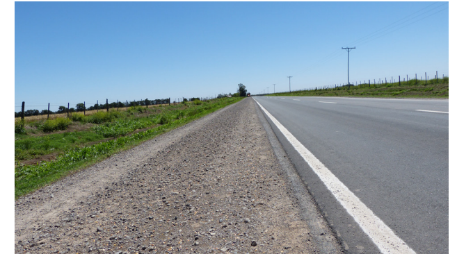
CONSTRUCCIÓN CAMINO ALTERNATIVO
